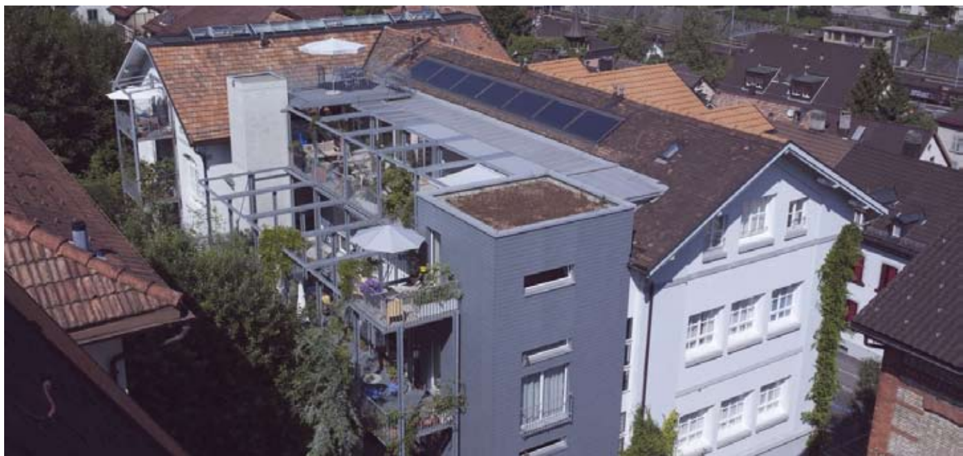
Saniertes Fabrikgebäude mit Zubau
